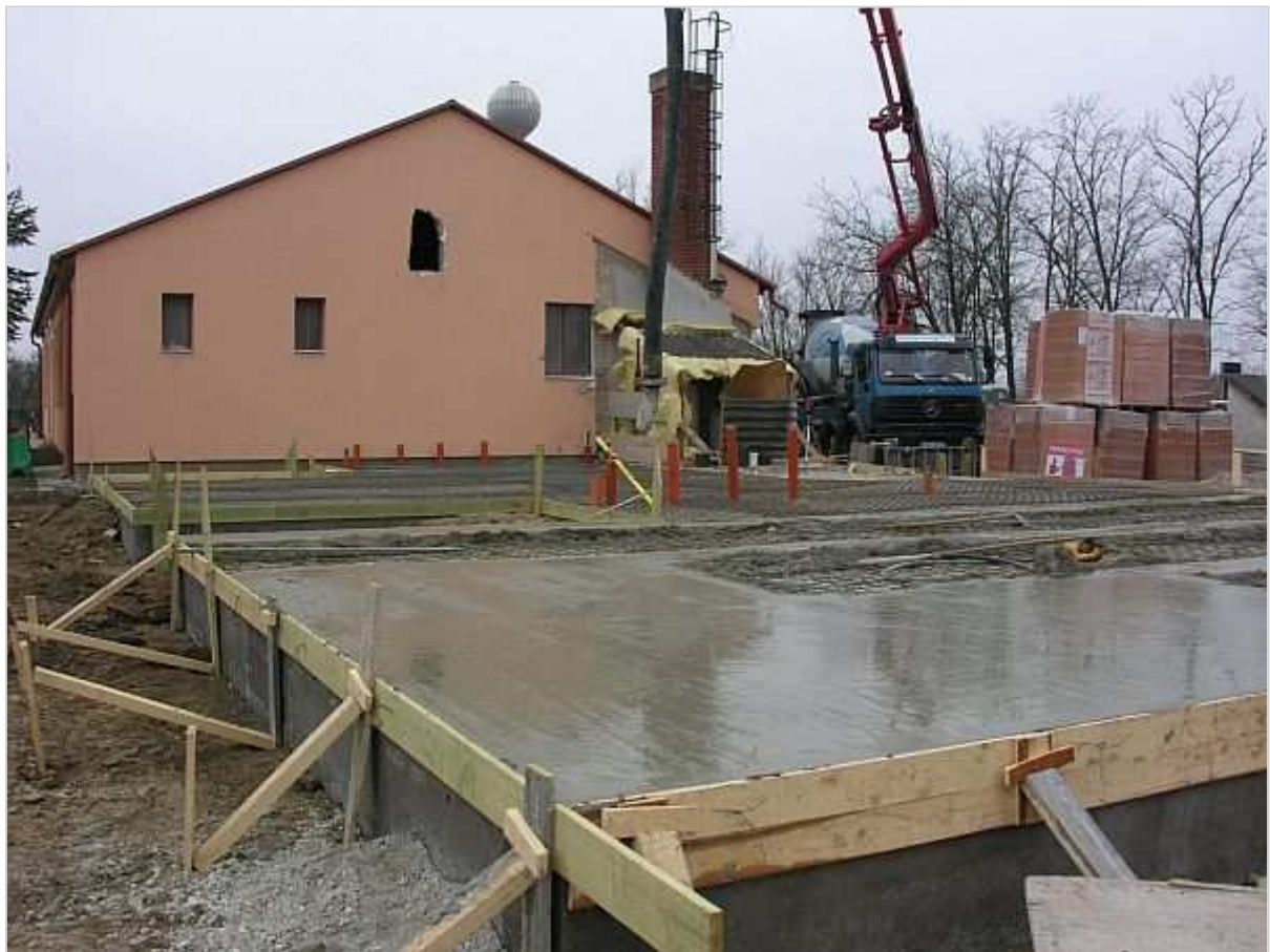
A kivitelező átvette a munkaterületet, jelenleg a külső munkákat végzik el.
